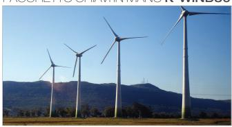
Potenza nominale: 30 kW Diametro rotore: 11 metri
